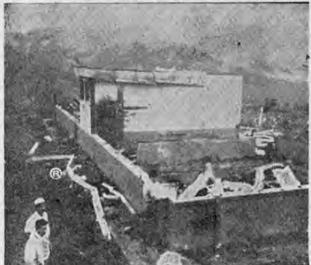
DESTRUCCION TOTAL. Las fotos muestran lo que quedó de la escuela de El Yas, destruida por misterioso incendio que se declaró ayer. (Foto de MOYA).
